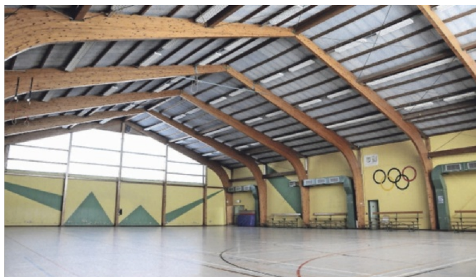
Gute Nachricht für die Nutzer der Mehrzweckhalle Herbesthal: Das Geld für eine Erneuerung des Sportbodens ist bewilligt.
