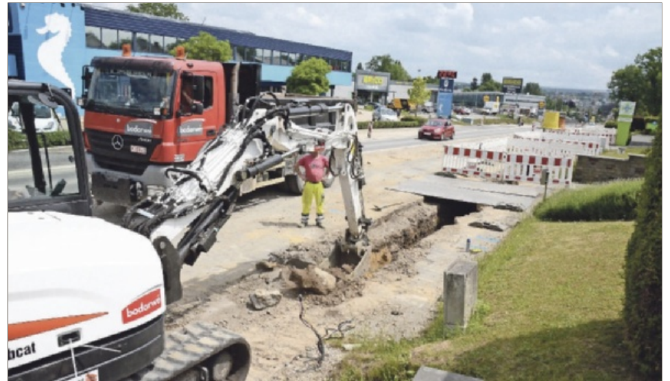
Kein Ende in Sicht: Die Arbeiten an der Herbsthaler Straße sollen sich noch Monate hinziehen. Foto: Ralf Schaus
