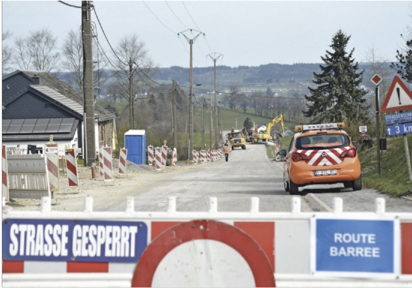
Eigentlich kein kommunales Projekt, aber dennoch in aller Munde: die Grunderneuerung der Regionalstraße, die Amel mit St.Vith verbindet. Fotos: GrenzEcho-Archiv
