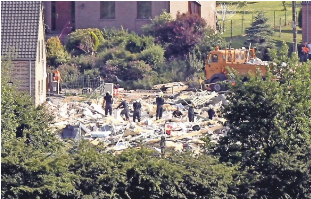
Von dem Wohnhaus in Soumagne blieb nach der Explosion im Juni 2010 nur noch ein Trümmerhaufen übrig. Ein junges Elternpaar und ein 20-jähriger Handwerker kamen darin ums Leben. Foto: belga
