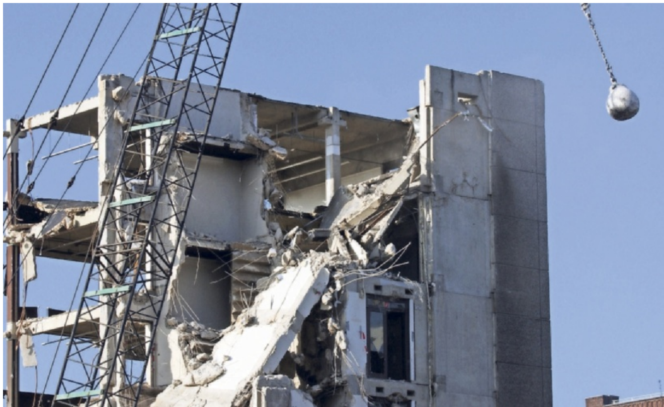
Mit einer Abrissbirne wird ein Hochhaus in Düsseldorf abgerissen.
