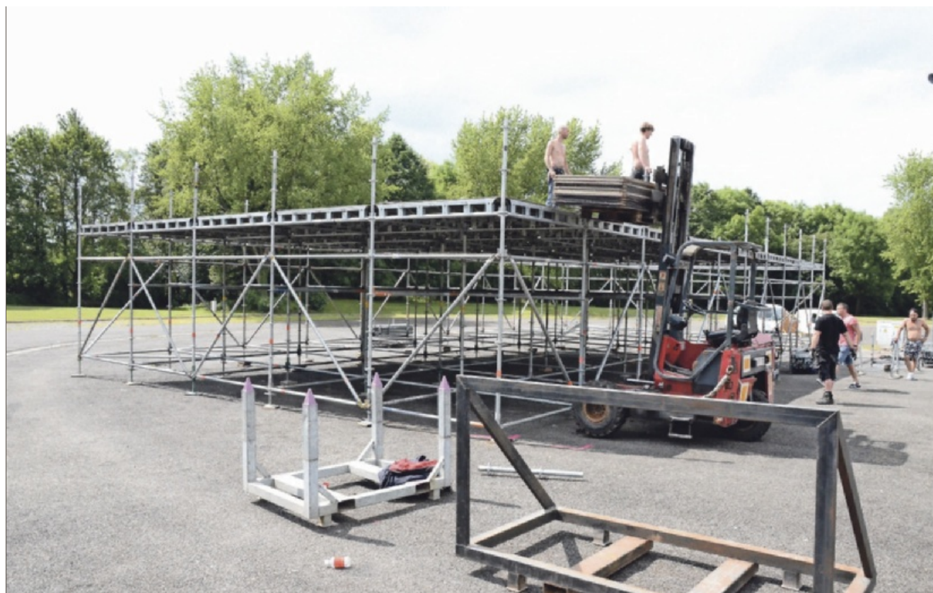
18 Meter lang und acht Meter hoch soll die Bühne für das Electro-Festival in Kelmis werden. Außerdem haben die Organisatoren, die Hallenfußballer vom MF Dolphins, ein System mit Planen für das Bühnenbild erdacht. Fotos: Ralf Schaus
